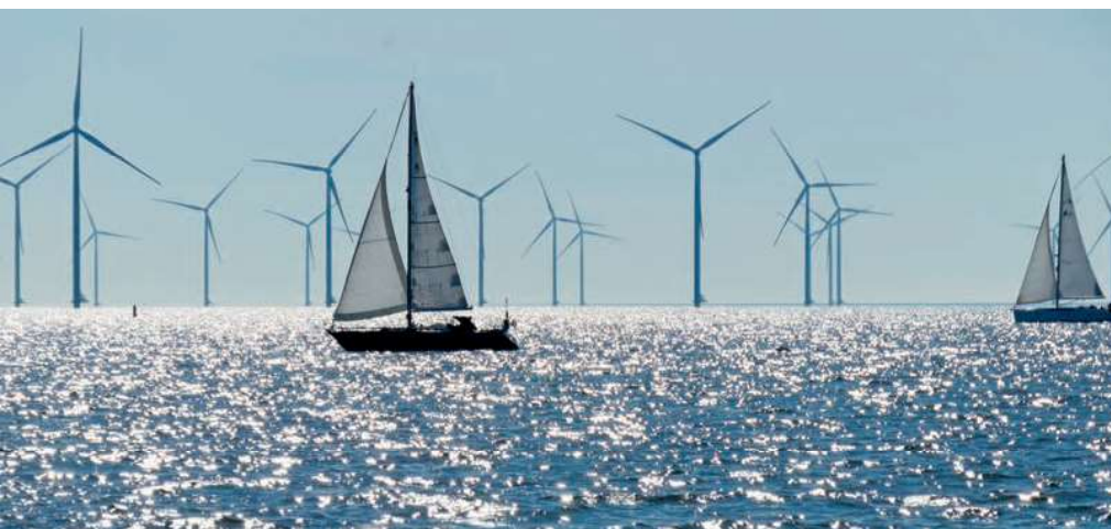
Befahrbarer Windpark Fryslân im IJsselmeer
